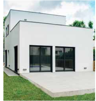
Nyt passivt hus i Sant Cugat del Vallès (Spanien)
