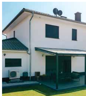
Nyt hus i Erlensee nær Frankfurt am Main (Tyskland)
