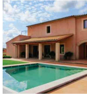
Førsteklasses passiv renoveringsvilla "Proyecto Tierra" i Lluçmajor, Mallorca (Spanien)
